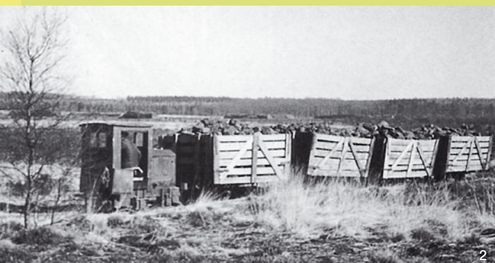
Eine Lorenbahn schaffte bis 1975 die Torfsoden aus dem Moor.
