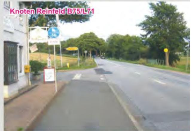
Ein ungesicherter und intransparenter Führungswechsel an Knoten in Überlagerung mit starken Kfz-Strömen stellt eine potenzielle Gefährdung des Radverkehrs dar.
