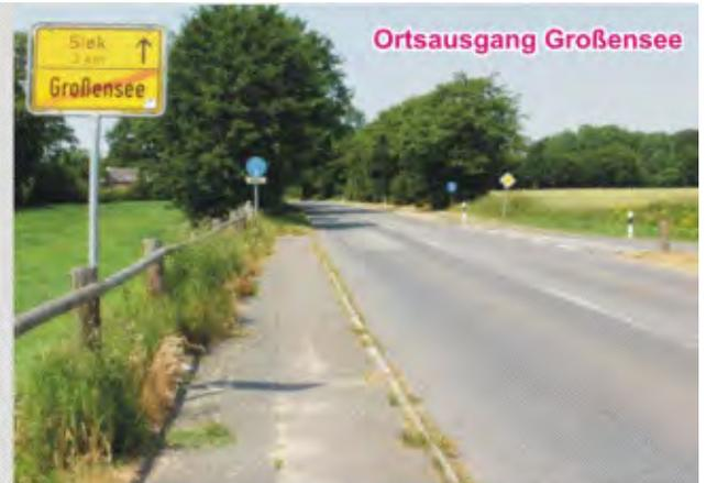
Ein häufiges Bild: Abrupt endende Radverkehrsanlagen am Ortsein- oder ausgang. Fast immer fehlen Überquerungshilfen, oft auch Hinweise zur weiteren Führung
